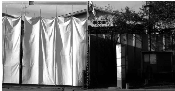
解体工事中の旧宮城支所会館 (仙台市青葉区愛子東6-4-5)
